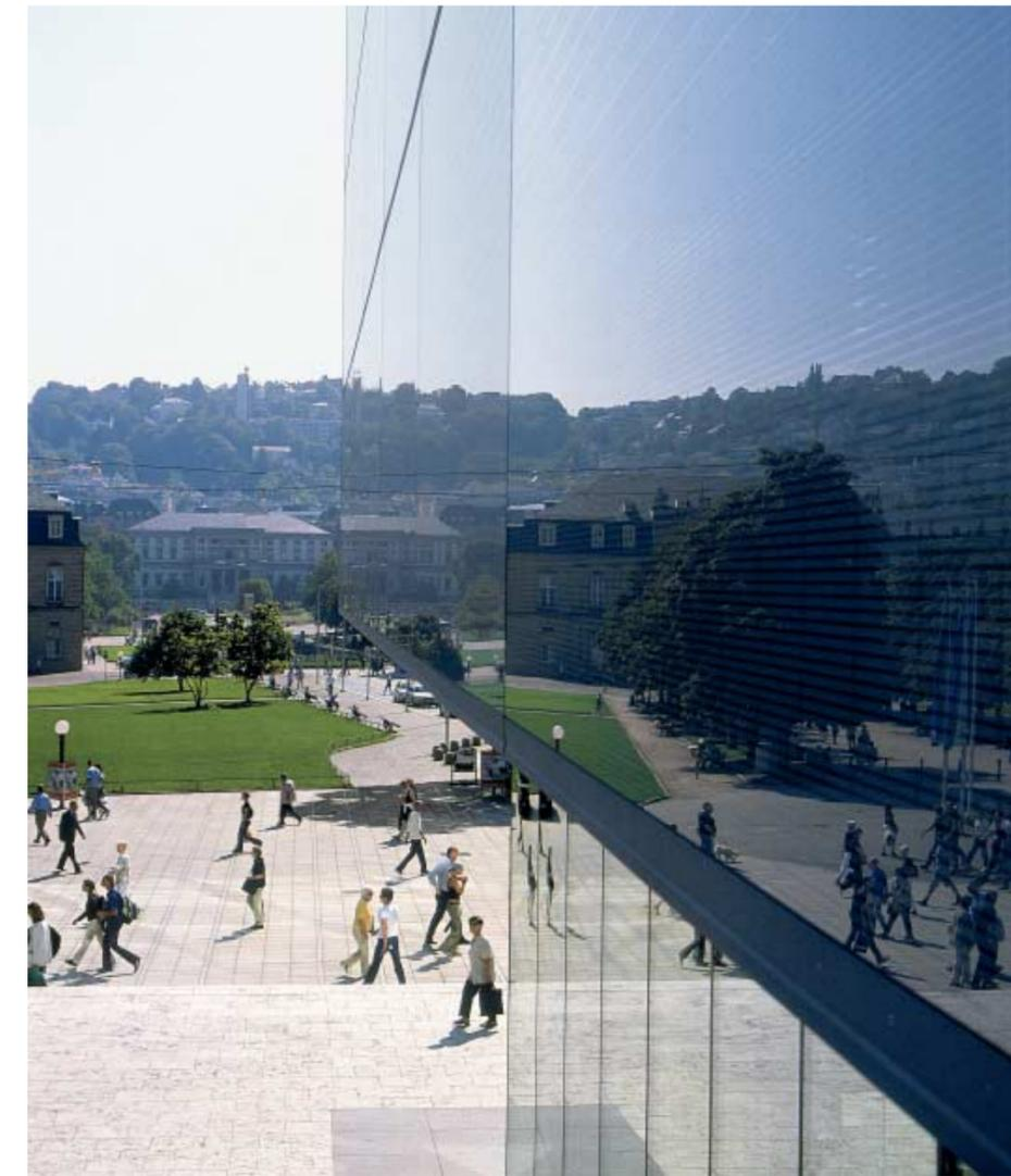
Das gläserne Fassadenfeld ist von einem kaum sichtbaren Trägerrost abgehängt. Horizontal bedruckte Bänder unterstützen die Sonnenschutzwirkung. Blickt man vom Museum zurück zur Planie, entdeckt man das Wilhelmspalais als städtebauliches Vis-à-vis.
