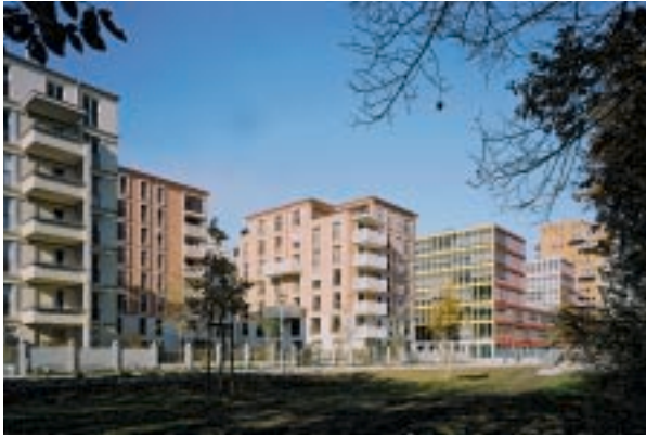
4. Blick von Südosten. Von links nach rechts: Haus 3 (Hilmer & Sattler und Albrecht), Haus 2 (Ortner & Ortner), Haus 1 (Ortner & Ortner), KPMG-Gebäude. 5. Blick von Südosten. Von links nach rechts: Haus 8 (Hilmer & Sattler und Albrecht), Haus 7 (Ortner & Ortner), Haus 5 (Ortner & Ortner), Haus 3 (Hilmer & Sattler und Albrecht), Haus 1 (Ortner & Ortner).
