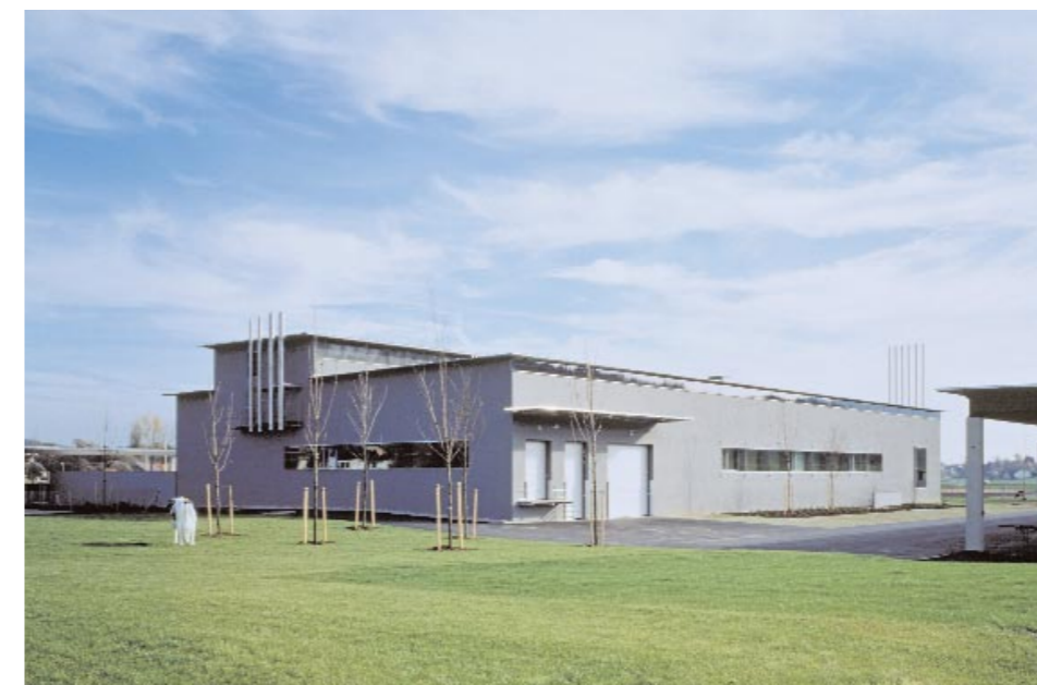
Die Rückseite des Hauptgebäudes. Zusätzliche Fenster, Transportöffnungen und Abluftkamine sind in den Baukörper integriert.
